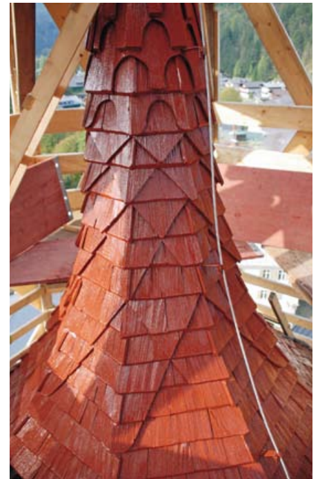
▲ Glänzendes Finish: Zum Abschluss wurde die Deckung mit einer Dickschichtlasur versehen
