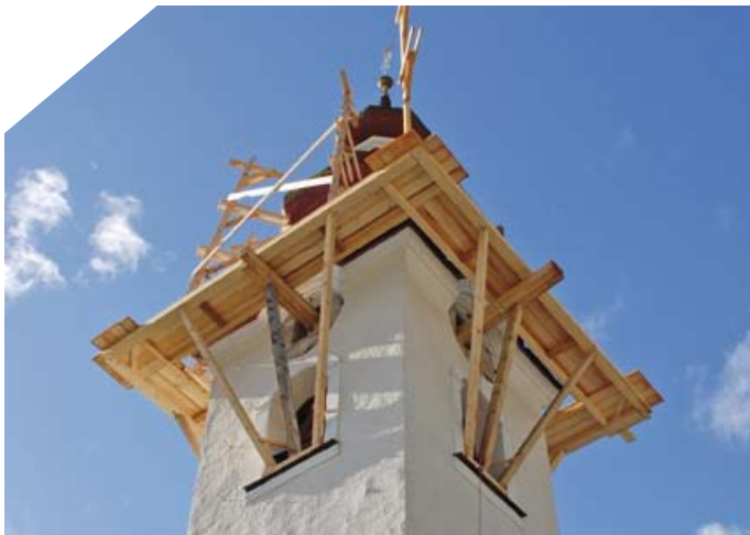
▲ Um die Schindeln verlegen zu können, mussten die Handwerker zunächst ein aufwendiges Holzgerüst anfertigen
