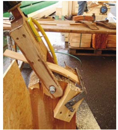
▲ Die unbearbeiteten Holzschindeln mussten vor der Verlegung in der Werkstatt zunächst in einem großen Zuber sorgfältig weichgekocht und anschließend entsprechend der komplizierten Geometrie des Zwiebelturms in einer speziellen Lehre gebogen werden
