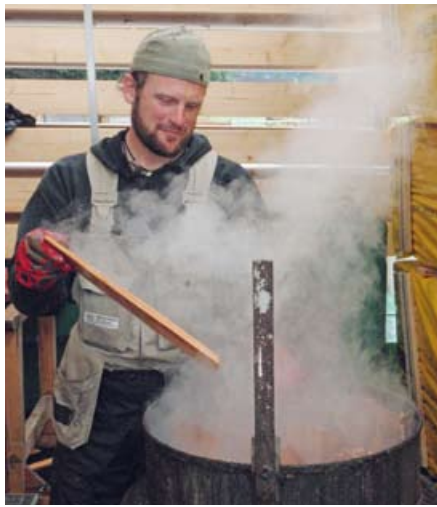
▲ Die unbearbeiteten Holzschindeln mussten vor der Verlegung in der Werkstatt zunächst in einem großen Zuber sorgfältig weichgekocht und anschließend entsprechend der komplizierten Geometrie des Zwiebelturms in einer speziellen Lehre gebogen werden
