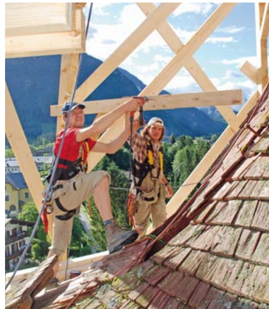
► Allein für die komplizierte Einrüstung verbrauchten die Zimmerleute 19 m 3 Holz
