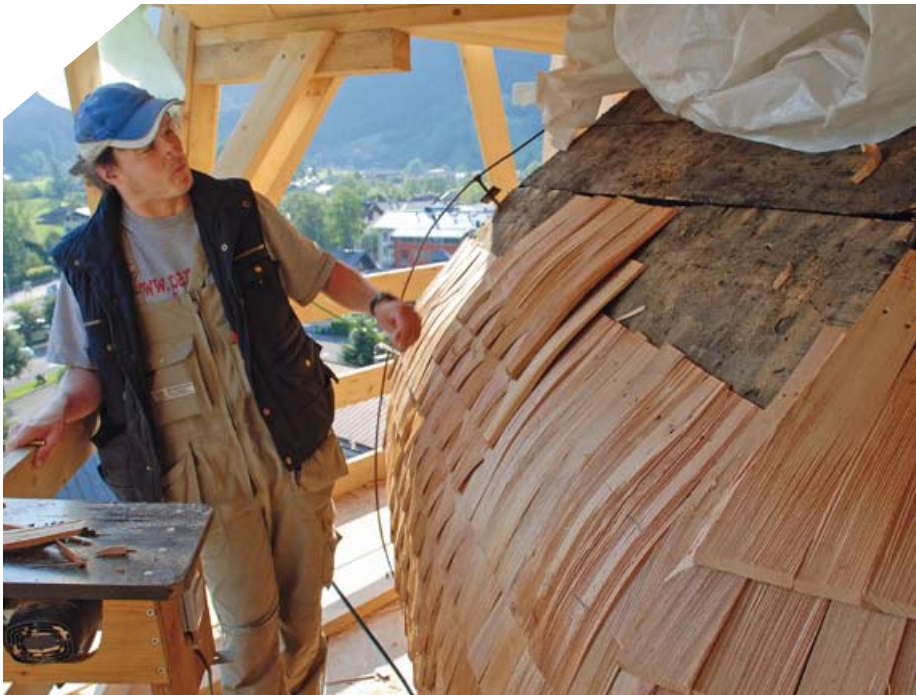
▲ Zuverlässige Regensicherheit: Die einzelnen Holzschindeln wurden von den Handwerkern so verlegt, dass sie einander um bis zu 20 cm überlappen
